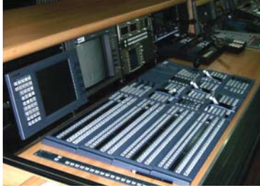
부조정실 스위처 Console(공사 후) 8
