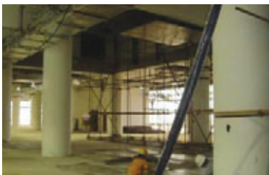
[WBM2 답사사진 - 공사 중인 주경기장, 수영장, IBC-MBC]
