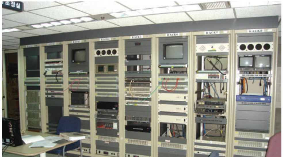
[간선 라인 부분 철거 & Rack 철거 & 전기접지 라인 해체]
