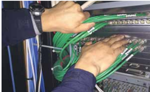
그림 3. VMU의 Rear Panel에서 물리적인 여유 Port 확인 장면
