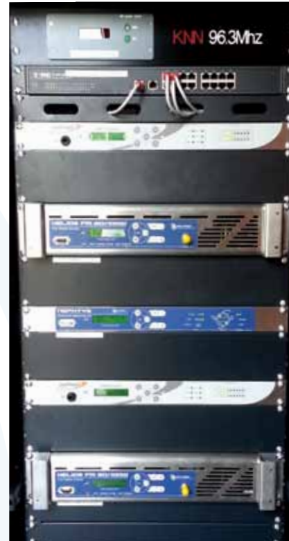
그림 3. 송신기 시스템 Rack실장
