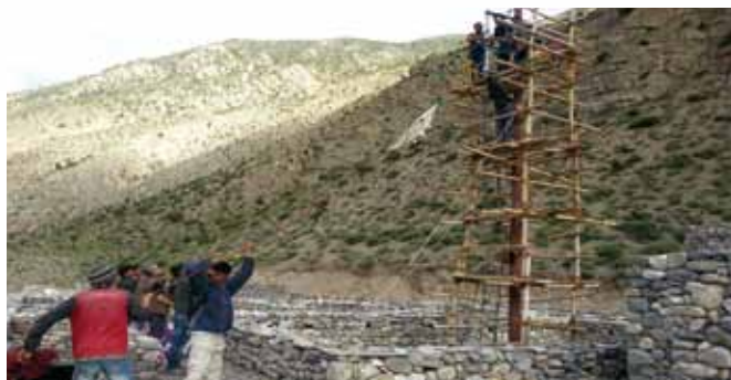
송신탑 건설 중
