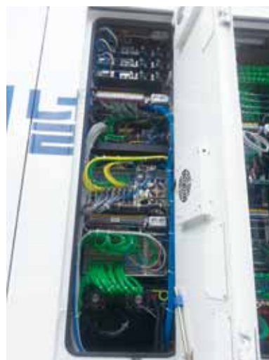
그림 4. 점검 도어 및 케이블링 상태
