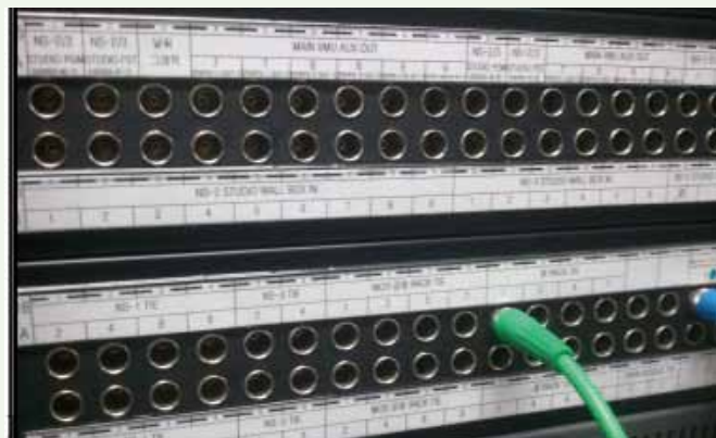
[그림 3] Baseband에서 N:N 통신을 위해 사용하는 Patch-panel/Router
