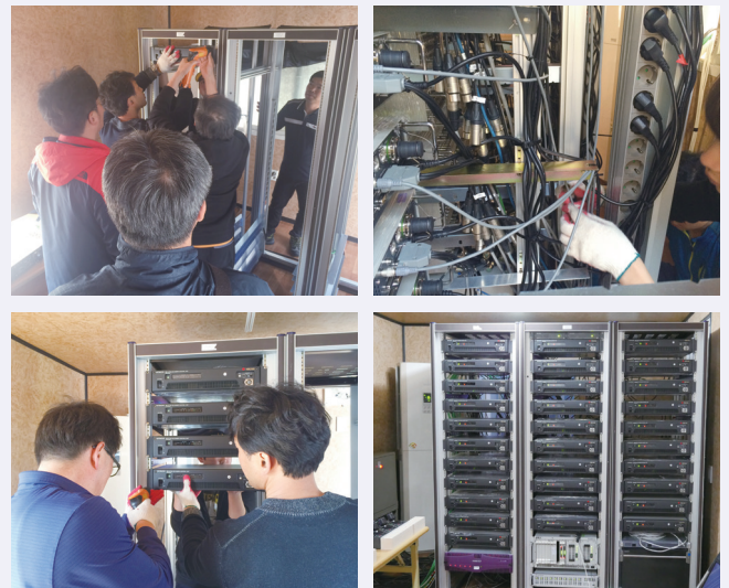
[그림 2] RACK에 주요장비 설치 과정
