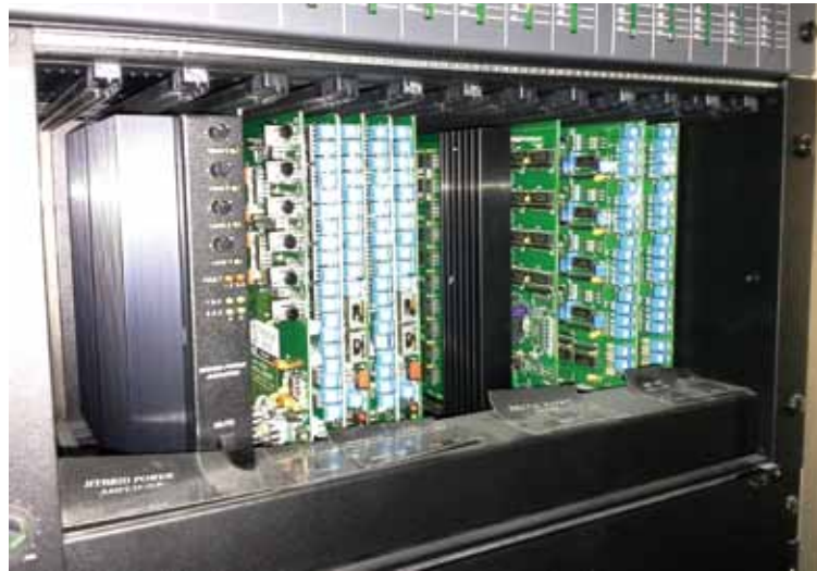
[그림 6] 전관방송 믹서 시스템 조절부
