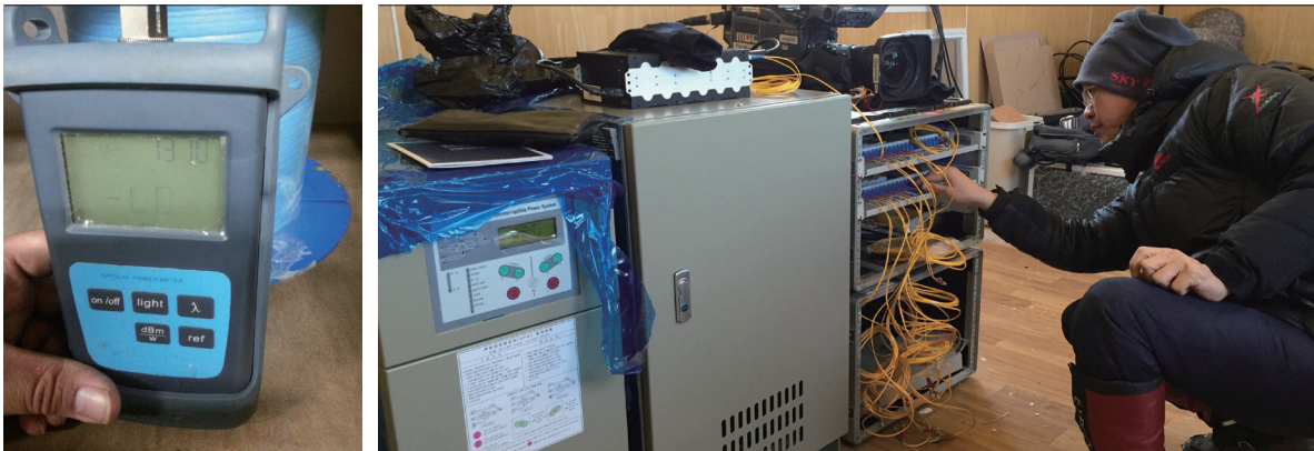
그림 9. 광신호 측정기와 광신호 테스트 중인 장면
