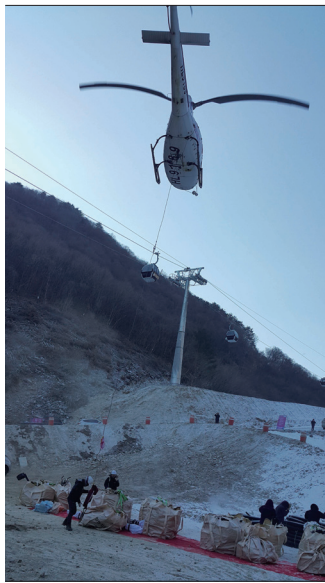
그림 6. 헬기를 이용한 장비 운송
