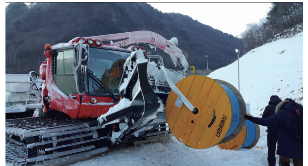
그림 3. 광케이블 드럼 설치 중
