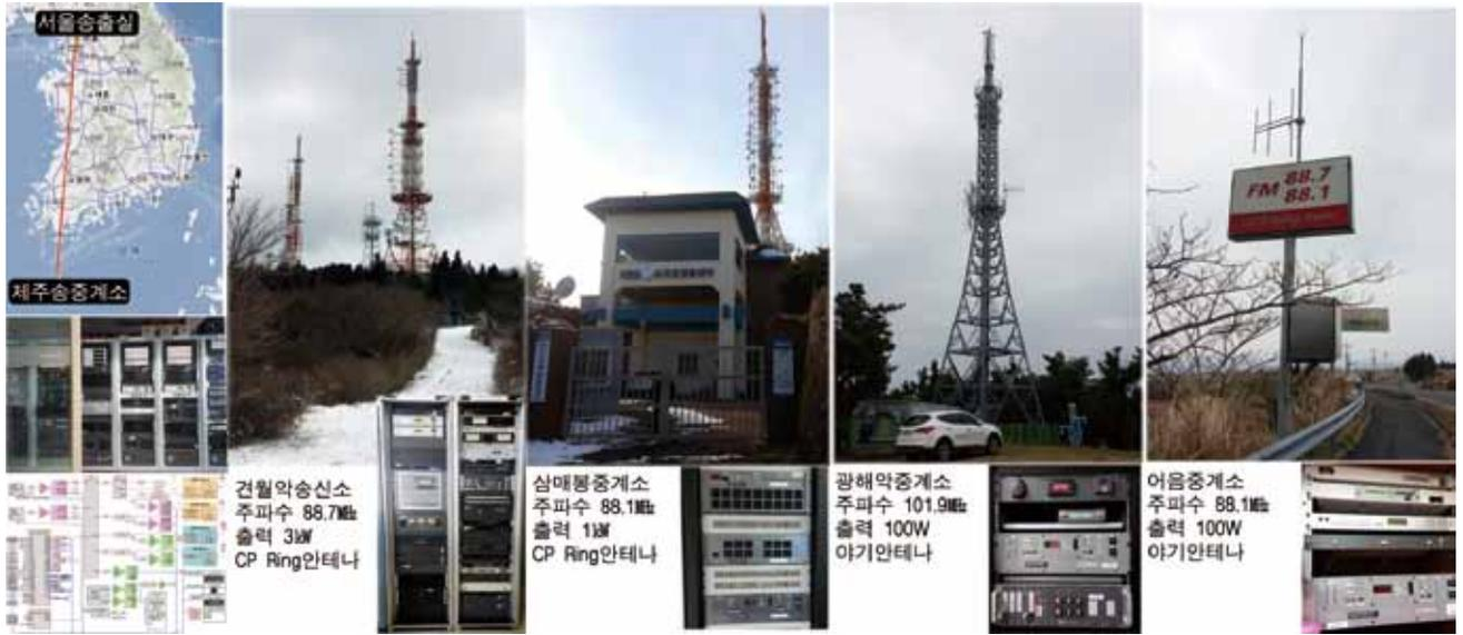
송신소는 한라산 동편 능선 건월악(개오리오름, 해발 약 700m)에서 주파수 88.7MHz/출력 3kW/CP Ring 안테나로 제주지역과 동부지역을 주 방송구역으로 한다. 서귀포 황우지해변과 외돌개를 감싸 안은 삼매봉(88.1MHz/1kW/CP Ring 안테나), 넓게 오름의 광해악(101.9MHz/100W/아기안테나), 평화로와 산록서로가 만나는 어음교차로의 어음방송보조국(88.1MHz/100W/아기안테나)은 제주남서부지역을 서비스한다.
