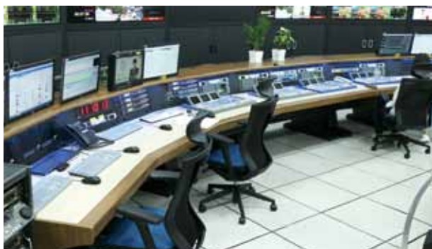
TV통합주조 하단 - 편성운영, 그래픽 작업 등 송출 사전작업 공간
