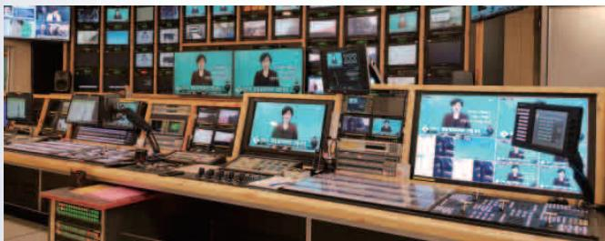
SBS는 UHD 부조정실을 구축 완료하고 UHD/HD 동시 라이브방송을 제작 송출하였다. UHD/HD 동시 라이브 제작시스템은 보도프로그램의 고화질 영상이라는 새로운 지평을 열었다는데 의미가 있다. 또한, 뉴스제작뿐 아니라 중계부조의 역할과 기능을 고려한 설계로 차세대 방송 제작에 중요한 교두보로서 역할이 기대된다.
