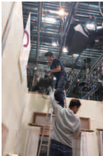
2인 1조 등기구 설치 작업
