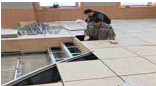
주조정실 2단 단내림 공사
