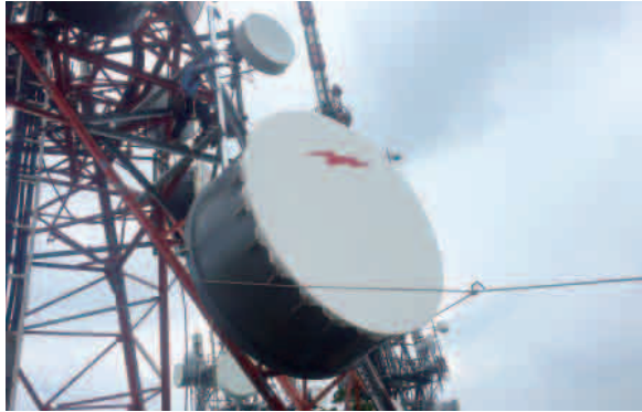
관악산 - EBS 통합사옥 옥상 M/W 안테나 설치
