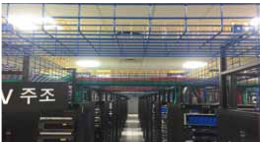
통합장비실 상부 트레이 공사
