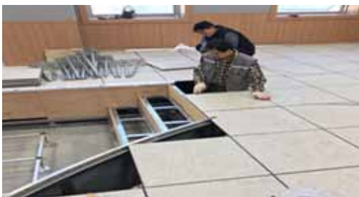
주조정실 2단 단내림 공사
