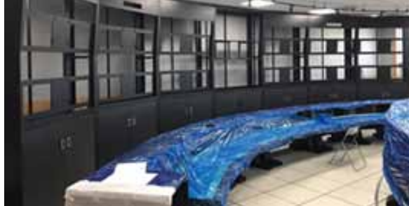
통합 주조정실 콘솔데스크 및 월 하우징 설치 공사
