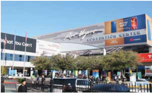
컨벤션 센터의 Central Hall 외관
