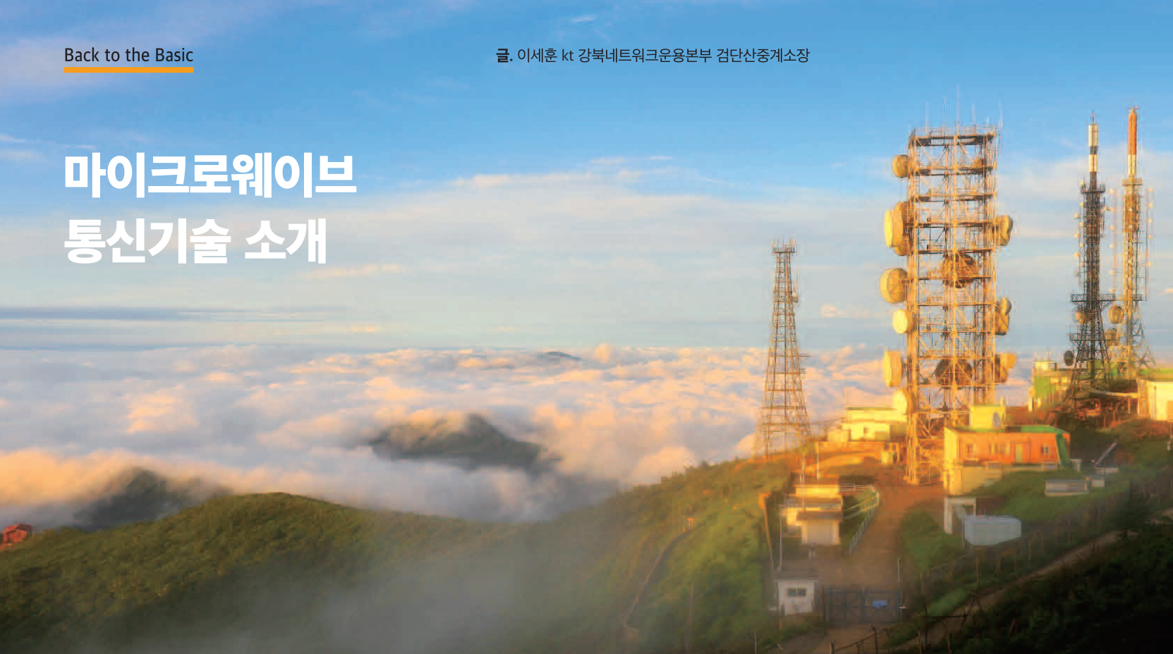
강원도 해발 1,573m 함백산 마이크로웨이브 통신소
