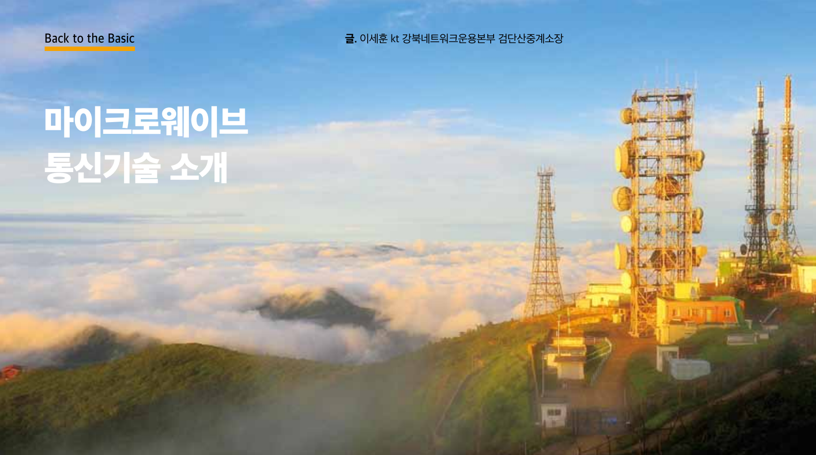
강원도 해발 1,573m 함백산 마이크로웨이브 통신소
