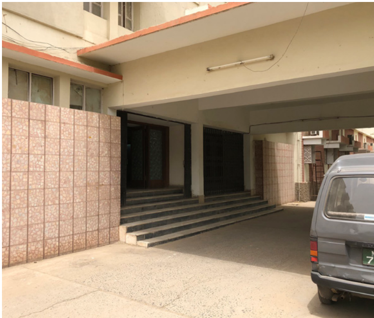
세월이 느껴지는 건물 외관 및 시설
