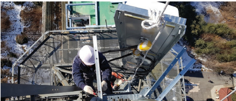
UHF 4K용 안테나 인양 및 설치 (북감악 송신소)
