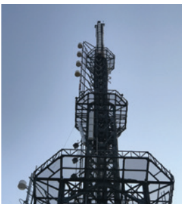
설치 완료 후
