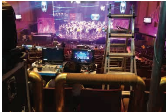
그림 9. Aerial Production System 컨트롤러 설치 모습
