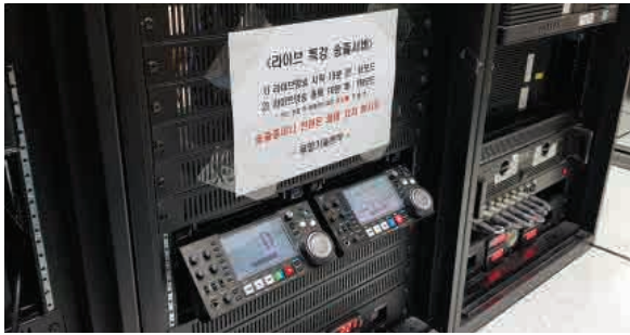
블루레이 데크 설치
