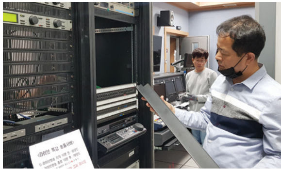
임시 송출 시스템 설치
