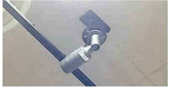
그림 26. CCTV 설치 모습
