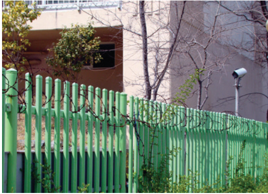
아파트에 설치된 담장
