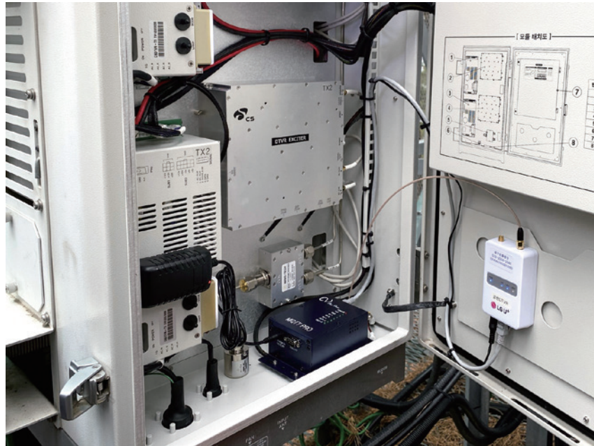
그림 8. 옥외형 중계기 내부 설치
