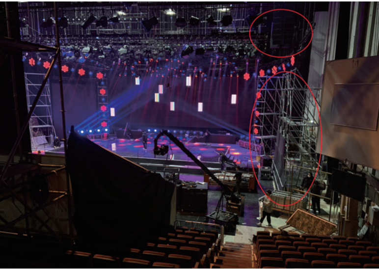
그림 8. LED 세트가 기존 하우스 스피커 위치보다 높음
