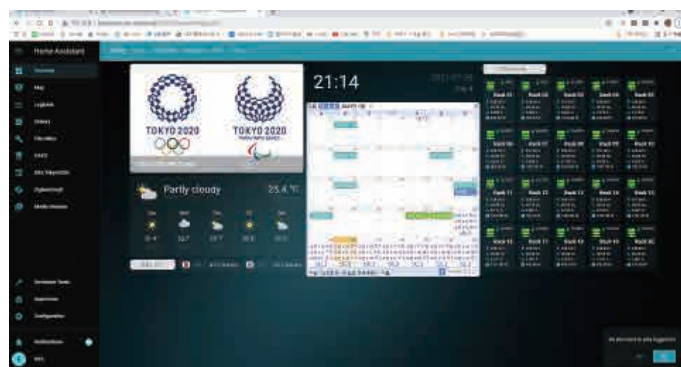
CTA 장비 Rack 전원 모니터링 시스템
