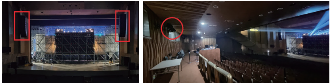
그림 2. 무대를 둘러싼 세트에 의해 홀에 설치된 스피커와 마이크를 사용하기 힘든 상황
