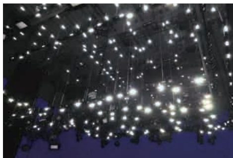
그림 10. 스튜디오 천장 그리드, 조명 바턴, 계단 등에 부착된 마커
