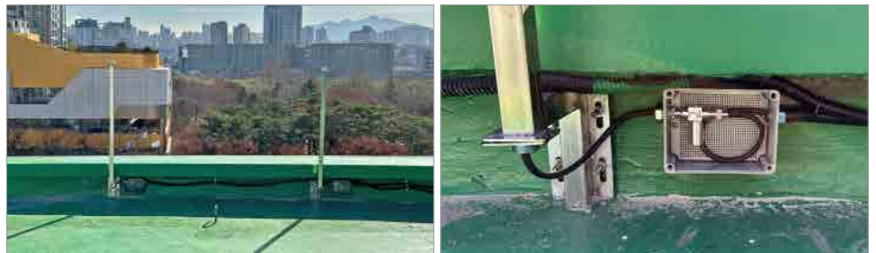
그림 9. GPS ANT, 낙뢰 보호기 설치 모습
