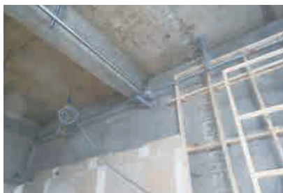
소화가스 배관 설치
