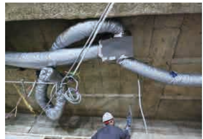
스튜디오 배관 설치
