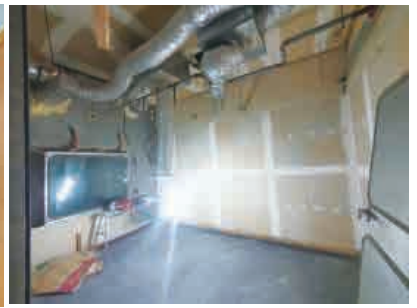
천정 및 마감재 철거
