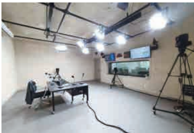
스튜디오 조명 설치
