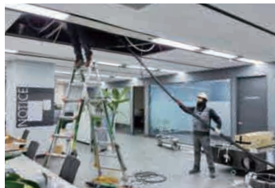
냉매 배관 작업
