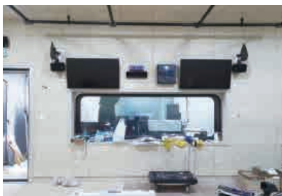
스튜디오 기구를 설치
