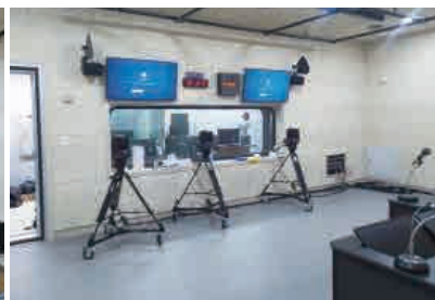
스튜디오 장비 설치
