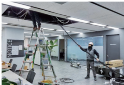
냉매 배관 작업
