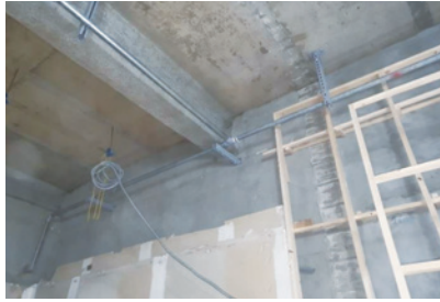
소화가스 배관 설치
