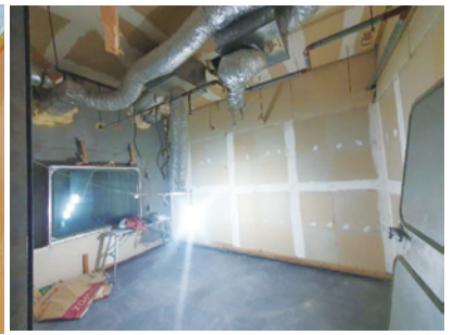
천정 및 마감재 철거
