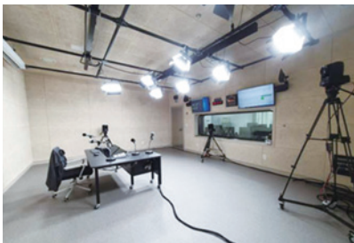
스튜디오 조명 설치
