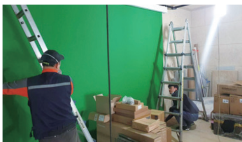
크로마키 스크린 설치
