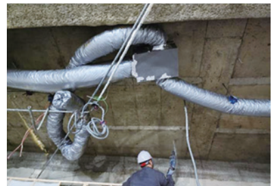
스튜디오 배관 설치
