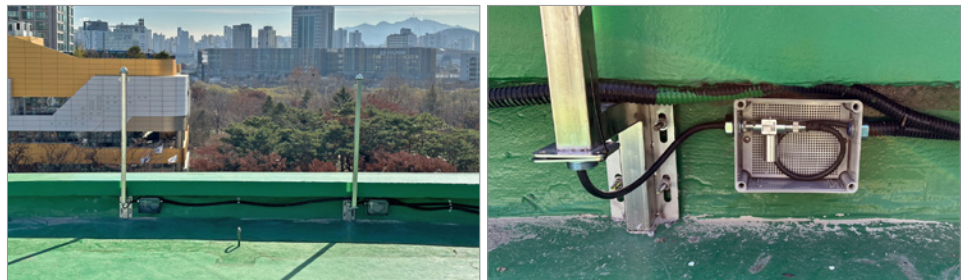
그림 9. GPS ANT, 낙뢰 보호기 설치 모습
