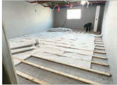
방진 바닥 설치(방진고무/흡음재)
