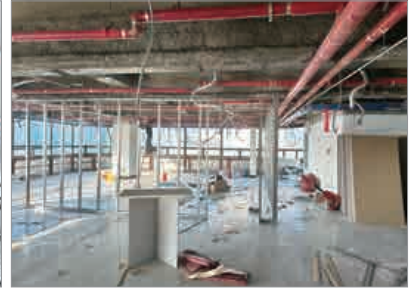
벽체 스테드 설치
