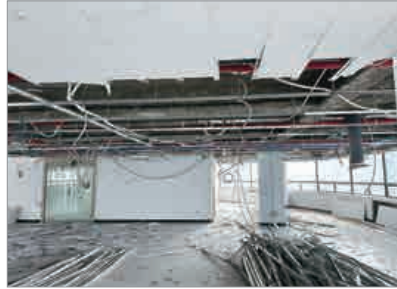
천장 철거 작업
