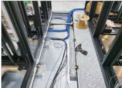
오디오 케이블 포설 작업
