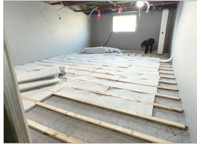
방진 바닥 설치(방진고무/흡음재)
