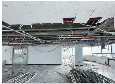
천장 철거 작업
