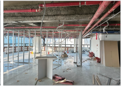
벽체 스테드 설치
