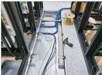
오디오 케이블 포설 작업
