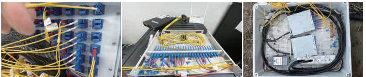
그림 3. 통제동 통신실 광회선센터 FDF(Fiber Distribution Frame, 광분배함) 및 발사대 사면 광 함체
