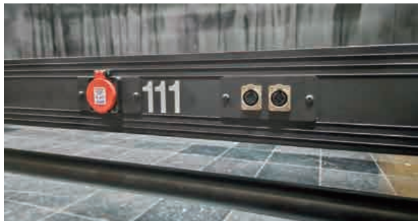
그림 11. DMX 3pin, 5pin 신호 분리
