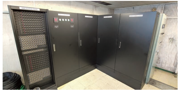
그림 16. 조광실 내 DMX Patch rack & RD rack
