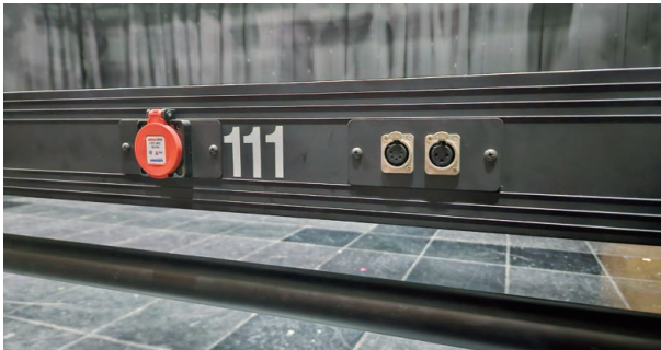
그림 11. DMX 3pin, 5pin 신호 분리
