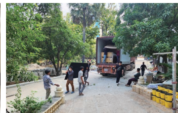
그림 9. 캄보디아 교육방송 구축 공사 현장
