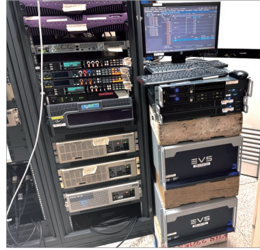
그림 10. 보강 설치된 LSM
