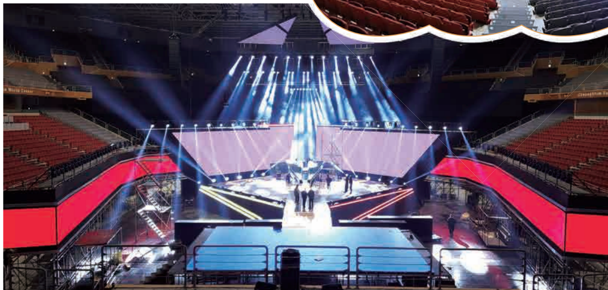
소년판타지 뮤직비디오 촬영현장과 조명 설치
