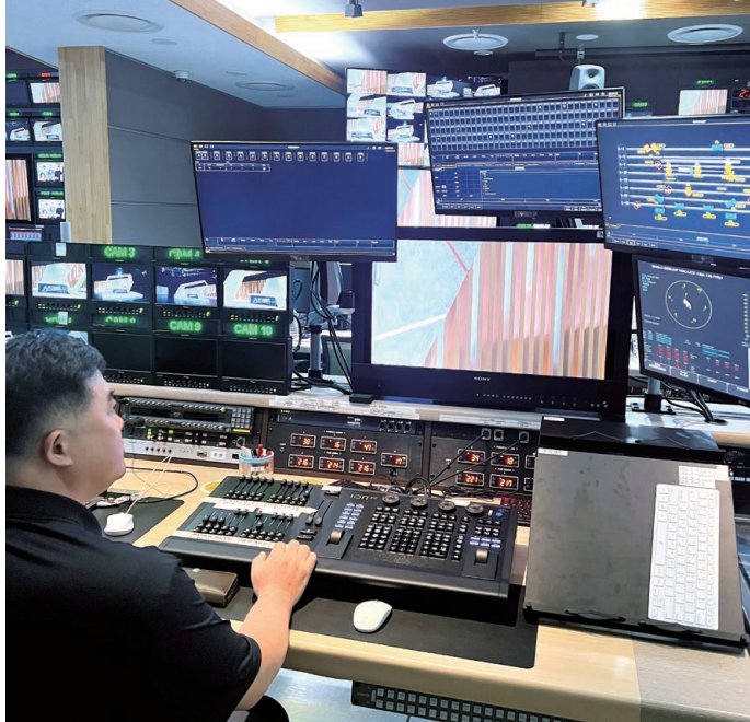
부조정실의 조명 작업
