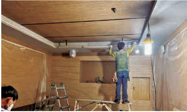
그림 6. 방음공사(4~5중 천장 마감) 및 방진공사
