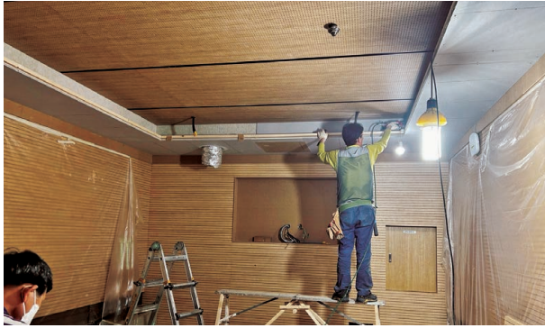
그림 6. 방음공사(4~5중 천장 마감) 및 방진공사
