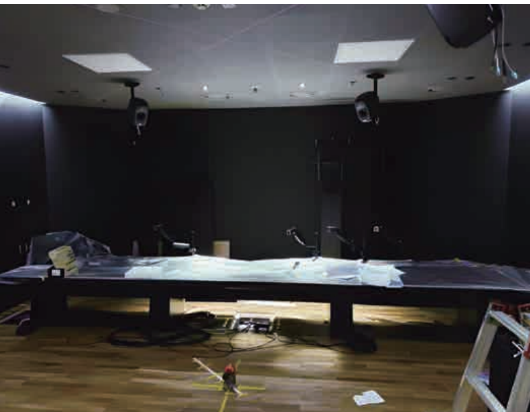
그림 15. ceiling 스피커 부분 재시공
