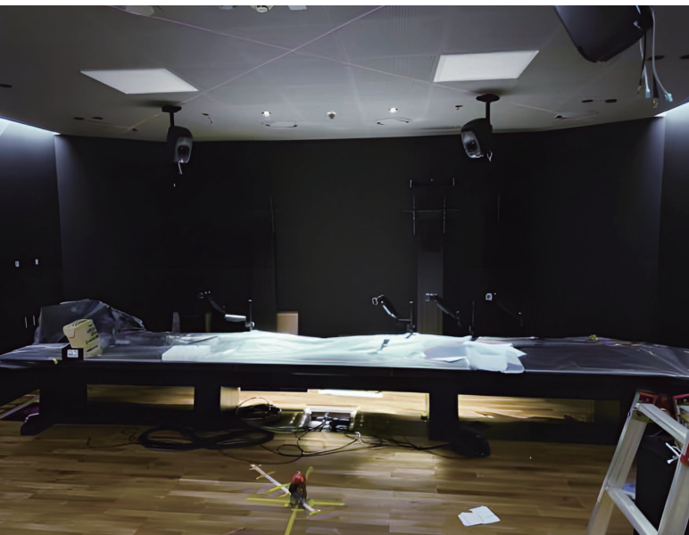
그림 15. ceiling 스피커 부분 재시공
