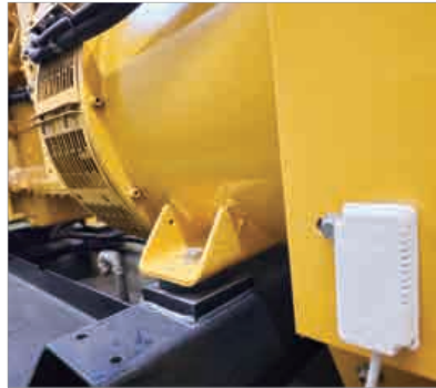
그림 6. 발전기 가동 검출 사운드 센서
