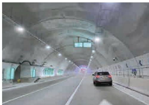
터널 내부 모습 (개통 전) (세종포천선 안성~용인 구간 중)
