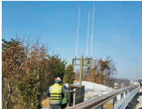
터널 수신 공용장치 (AM/FM/DMB) 및 광 전송장치
