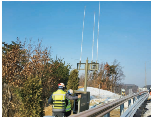
터널 수신 공용장치 (AM/FM/DMB) 및 광 전송장치
