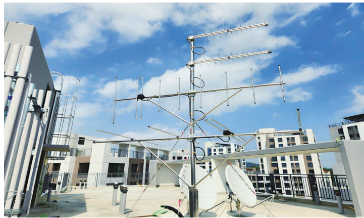
그림 4. 건축 옥상 안테나 수신설비 설치 사례
